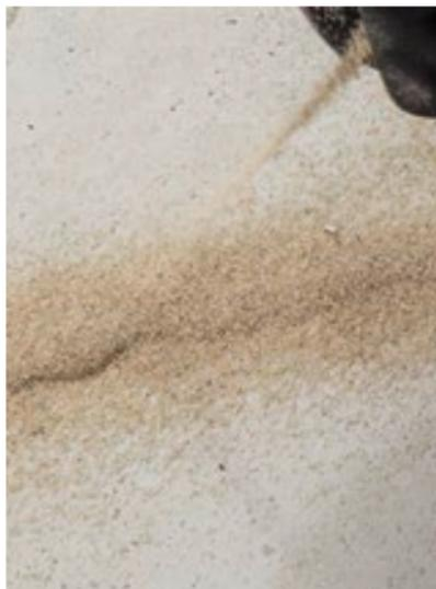
**5.** Den mit Harz gefüllten Riss mit Quarzsand absanden. Bei breiten und tiefen Rissen gegebenenfalls Schritt 4 und 5 wiederholen.
