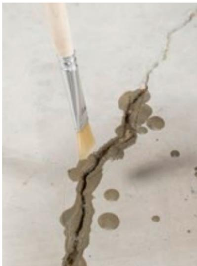
**6.** Applikation mittels Pinsel, Spatel etc. Riss mit Harz vollständig füllen.
