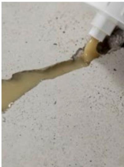
**6.** Applikation direkt aus der Flasche. Riss vollständig mit Harz füllen.
