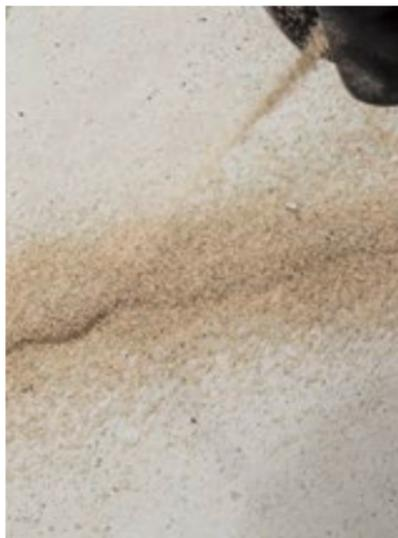
**7.** Den mit Harz gefüllten Riss mit Quarzsand absanden. Bei breiten und tiefen Rissen gegebenenfalls Schritt 6 und 7 wiederholen.
