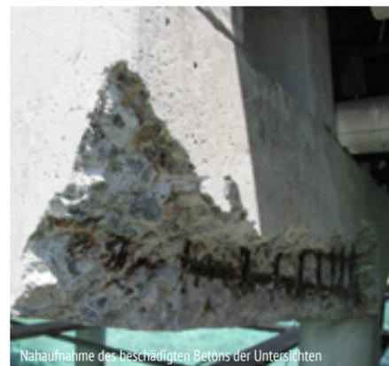
Nahaufnahme des beschädigten Betons der Untersichten
