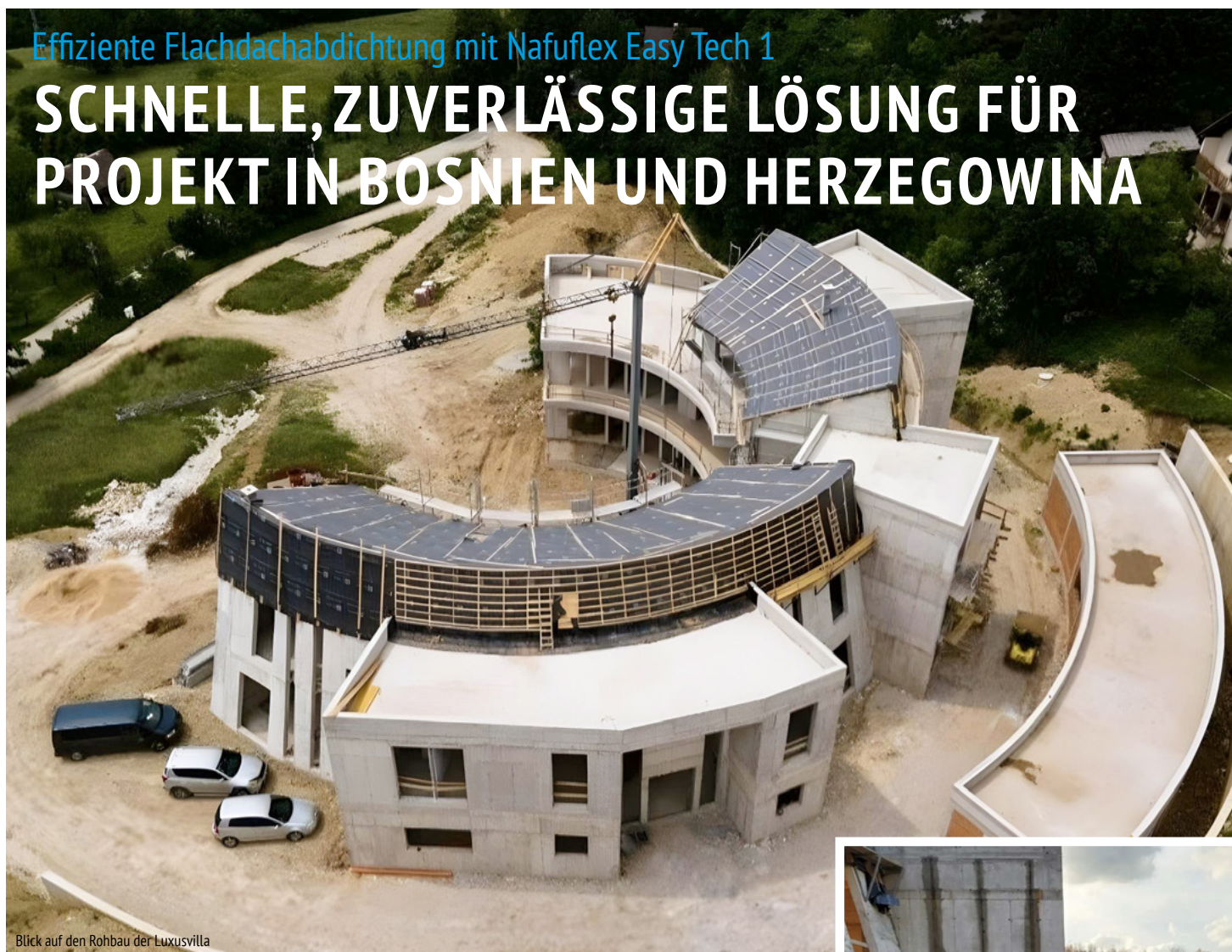
Blick auf den Rohbau der Luxusvilla
