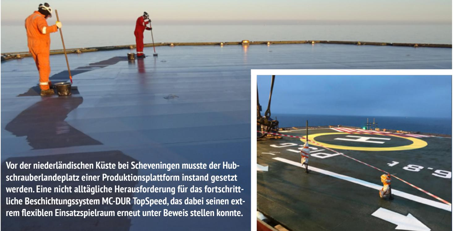
Vor der niederländischen Küste bei Scheveningen musste der Hubschrauberlandeplatz einer Produktionsplattform instand gesetzt werden. Eine nicht alltägliche Herausforderung für das fortschrittliche Beschichtungssystem MC-DUR TopSpeed, das dabei seinen extrem flexiblen Einsatzspielraum erneut unter Beweis stellen konnte.
