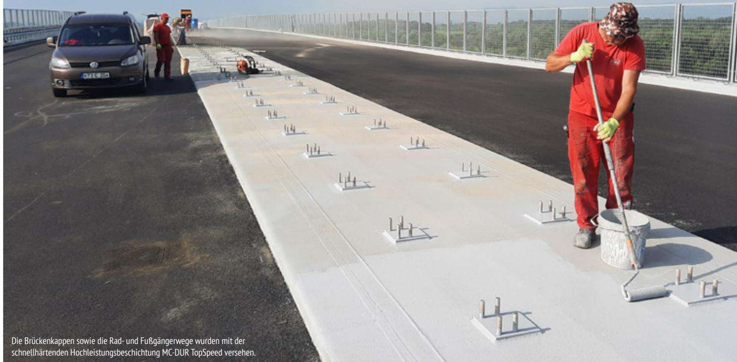
Die Brückenkappen sowie die Rad- und Fußgängerwege wurden mit der schnellhärtenden Hochleistungsbeschichtung MC-DUR TopSpeed versehen.
