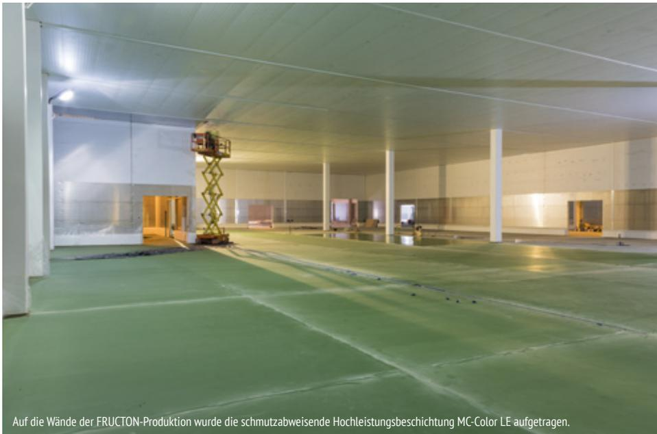
Auf die Wände der FRUCTION-Produktion wurde die schmutzabweisende Hochleistungsbeschichtung MC-Color LE aufgetragen.
