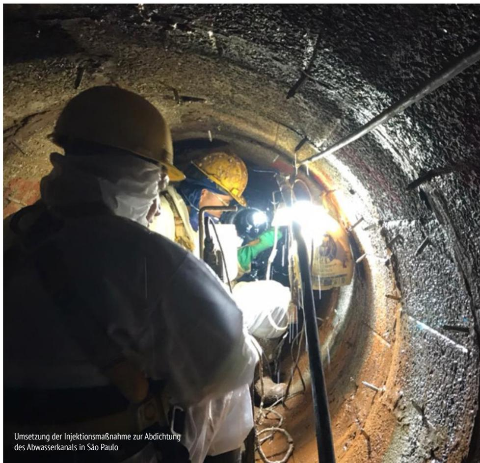
Umsetzung der Injektionsmaßnahme zur Abdichtung des Abwasserkanals in São Paulo
