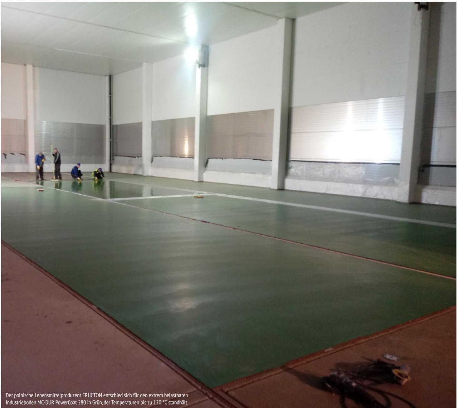
Der polnische Lebensmittelproduzent FRUCTON entschied sich für den extrem belastbaren Industrieboden MC-DUR PowerCoat 280 in Grün, der Temperaturen bis zu 120 °C standhält.
