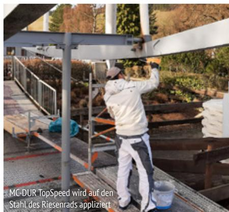
MC-DUR TopSpeed wird auf den Stahl des Riesenrads appliziert
